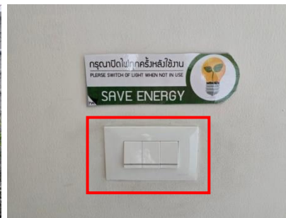
สวิตช์ไฟแบบแยกออกจากกัน
