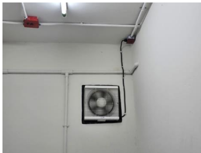
พัดลมระบายอากาศห้องพักมูลฝอยเปียก
